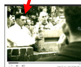
Bauarbeiten Theresianum 1963 Dauer 1:09 Min.
